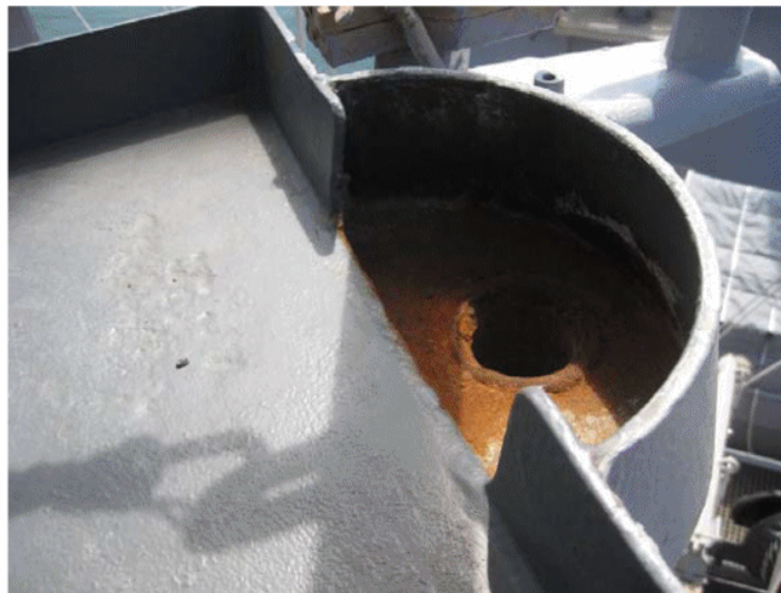
D. Coaming (Waterway Bar) At Deck Edge
