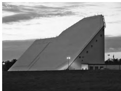
Figure 19-4. AN/FPS-85 PAR at Eglin AFB. (USAF photo)
